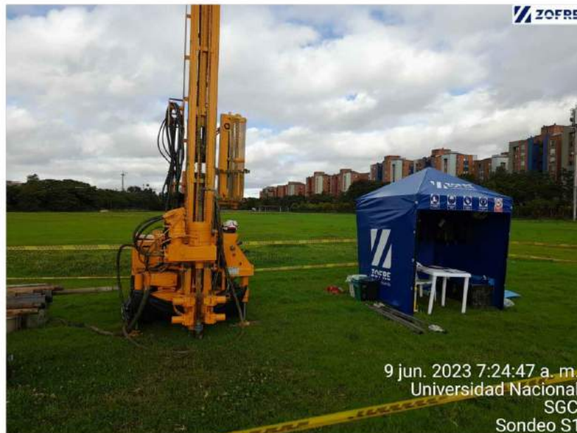
FOTO 2: Vista en detalle del sitio de emplazamiento del sondeo S1
