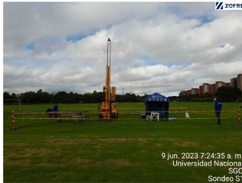
FOTO 1: Vista panorámica del sitio de emplazamiento del sondeo S1
