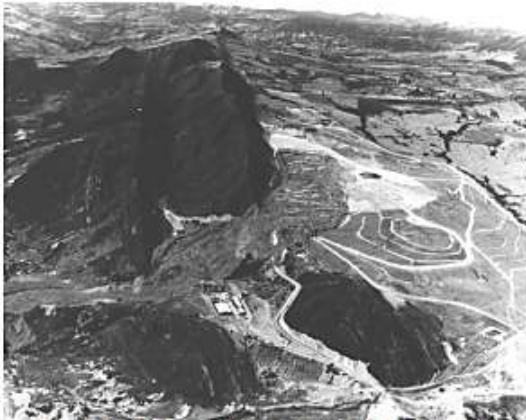
Foto 1 - Panorámica del Deslizamiento
