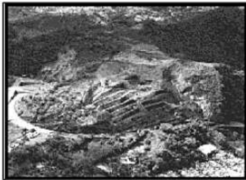
Fotografía 1. Panorámica del deslizamiento El Cune
