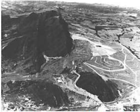
Foto 1 - Panorámica del Deslizamiento
