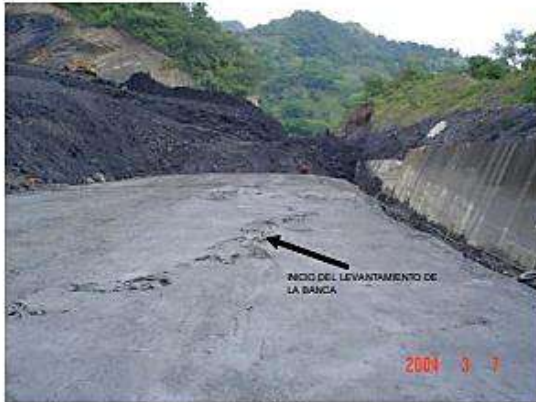
Fotografía 2. Levantamiento de la banca 7 de Marzo posterior al despeje de la banca y construcción del terraplén.
