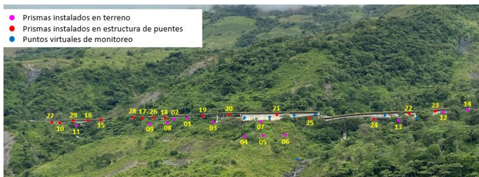
Figura 5. Ubicación de prismas en laderas y puentes. Chorro Blanco a la izquierda y Los Grillos a la derecha.
