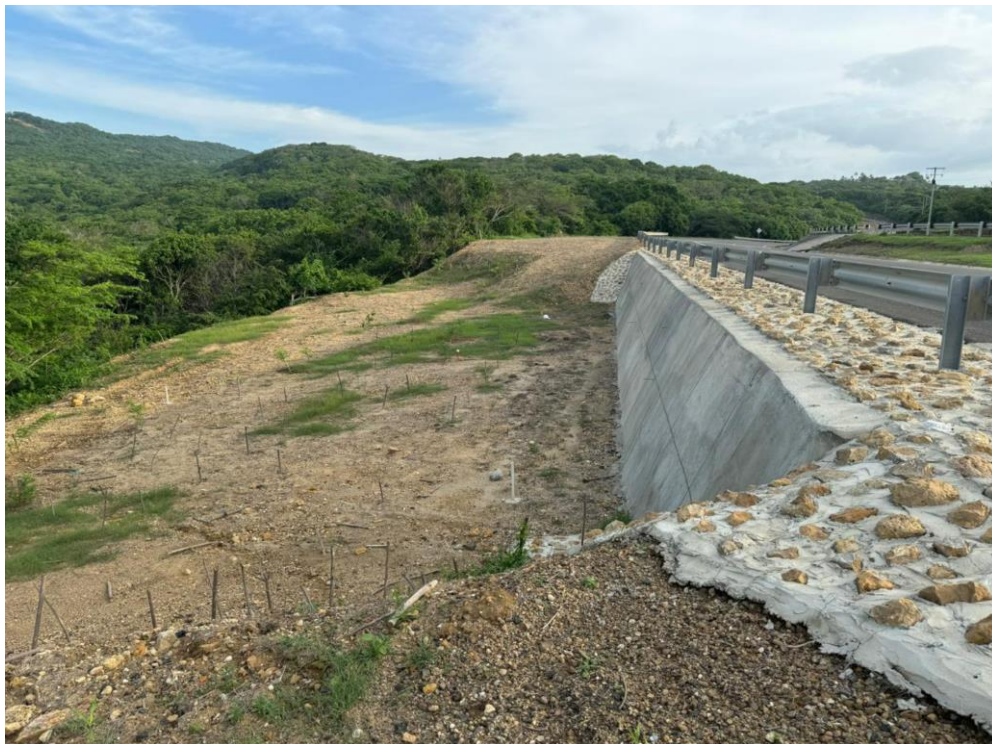
Figura 4. Estado actual de obras ejecutadas. Fuente: Propia (2022).
