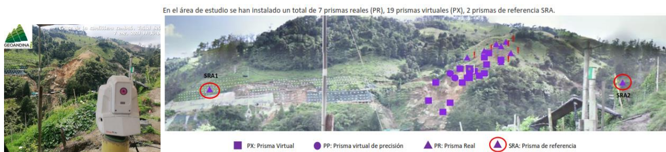
Figura 2. Despliegue de estación Lidar láser automatizada y prismas reales y virtuales.
