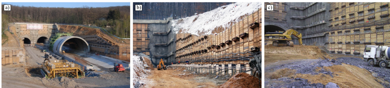
Figura 1. Vista general del túnel Komořany y estructuras de contención empleadas. Fuente: Mašín y Duque [1]
