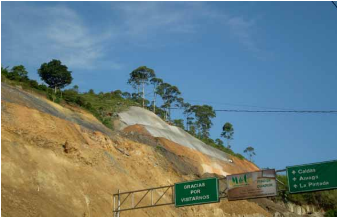
Fotografía 5. Doble calzada Ancón Sur (Extremo sur del Valle de Aburrá) - Primavera (Municipio de Caldas), donde se conectará con la proyectada Doble Calzada Primavera-Tres Puertas (Manizales) de las Autopistas de La Montaña. Fotografía tomada en el mes de julio de 2009, cuando apenas se iniciaba la construcción de la pantalla de anclajes para estabilizar el deslizamiento en suelos residuales y coluviones, generado durante la excavación de los taludes para la segunda calzada. Este tratamiento, que se está construyendo casi de manera extensiva en un trayecto de unos 4 km, ha significado cuantiosas inversiones (el presupuesto estimado para estos tratamientos es del orden de $52.000.000, $13.000 millones por km).
