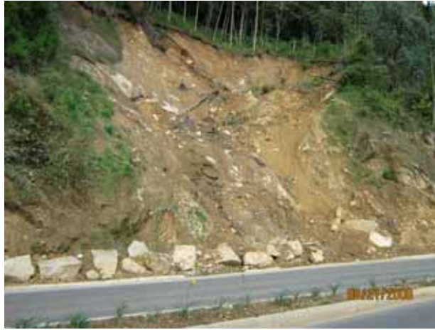
Fotografía 4. Deslizamiento en coluviones, según se observaba en julio de 2008) generado durante la construcción de la Doble Calzada a Las Palmas. Este movimiento de tipo regresivo avanzó ladera arriba, lo que obligó al cierre de la vía y a costosas intervenciones para la estabilización del talud.
