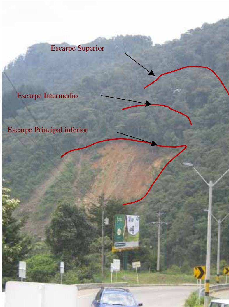
Fotografía 3. Panorámica (tomada en julio de 2008) del gran deslizamiento en el K3+200 en la vía a Las Palmas, que de Medellín conduce al Aeropuerto Internacional José María Córdoba, así como a la zona de gran desarrollo urbanístico, educativo y comercial del oriente cercano en el Departamento de Antioquia. Desestabilización de tipo regresivo (remontante) de un extenso depósito coluvial, generado durante la construcción de la segunda calzada, que avanzó ladera arriba hasta casi alcanzar la divisoria de aguas (cerca de 200 m por encima de la vía). Este deslizamiento, que obligó el cierre de la vía durante varias semanas, exigió un costoso tratamiento del talud con pantallas ancladas con tensores profundos y numerosos drenes sub-horizontales, así como la construcción de pantallas para la retención de caídos y seguridad de los usuarios.
